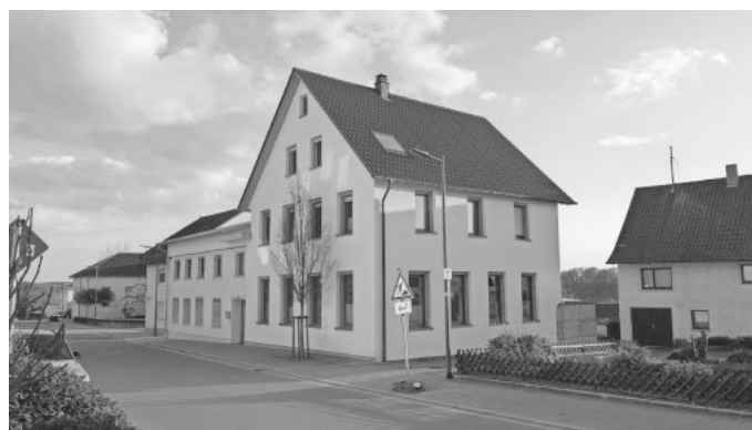
Erstes Betriebsgebäude in der Hauptstraße in Hohentenge (früheres Schulgebäude)
