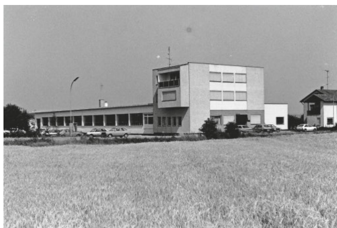
Zweites Produktionsgebäude in der Hau in Hohentengen, 1963 von Architekt Bleicher aus Bremen geplant. Herr Fimpel ließ es durch das damalige Baugeschäft Kessler aus Enzkofen erstellen und wurde von Herbert Müller übernommen.
