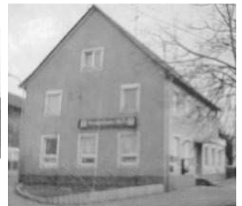
Altes Schulgebäude Ölkofen
