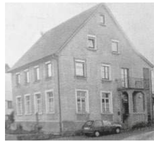
Altes Schulgebäude Ursendorf
