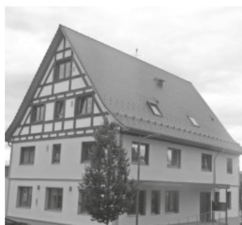
Foto: nach dem Umbau
