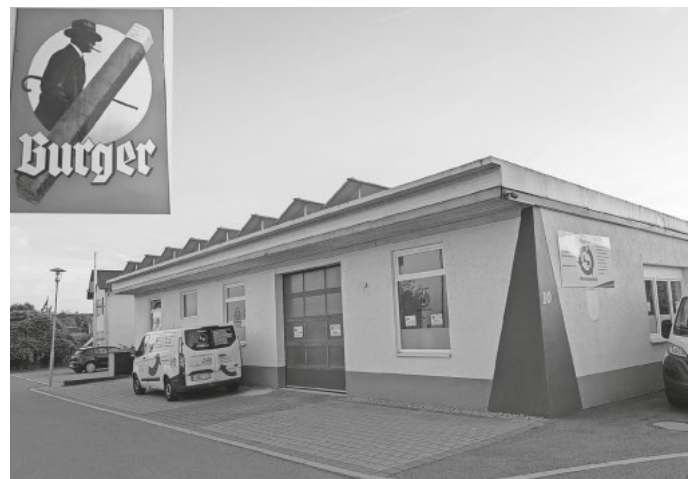
Die ehemalige Stumpfenfabrik in Beizkofen, Foto F. Ott
