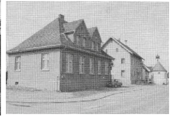
Altes Schulgebäude Beizkofen
