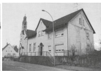
Altes Schulgebäude Günkofen
