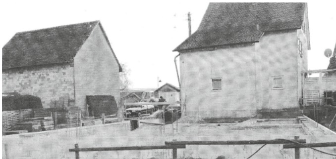
Die Hinteransicht des Gebäudes (Baujahr 1839) lässt erkennen, dass neben dem geplanten Anbau, ein ordentliches Stück Sanierung des Altgebäudes bevorstand.
