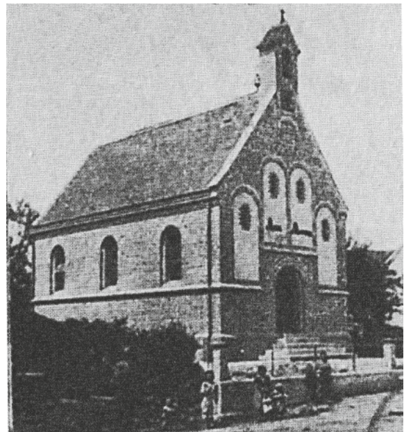
Die Kapelle im ursprünglichen Zustand mit dem einfachen, offenen Glockentürmchen (Vorlage: Bildarchiv H. Brendle)
