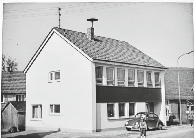
Das umgebaute Gebäude gleich nach der Fertigstellung
