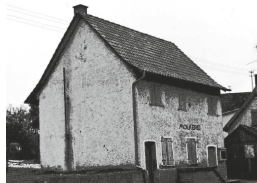
Ehemalige Molke von Ölkofen (abgebrochen)
