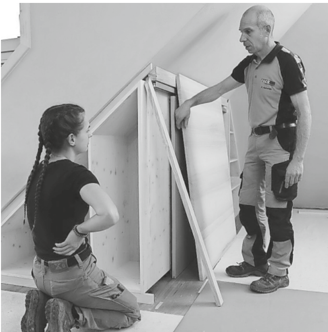
Die Montage des Einbauschranks war wegen der Dachschrägen sehr anspruchsvoll
