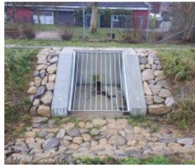
Verwallung mit Grundablass
