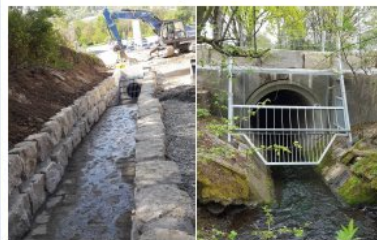
Einlaufbauwerke mit optimiertem Rechen
