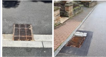
Optimierter Straßeneinlauf Bergeinlauf (mit Optimierung)
