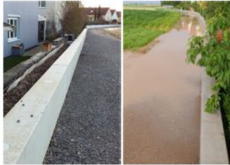
Mauer mit Rückhalt
