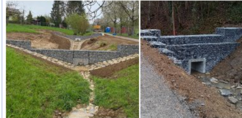
Geröllfang mit Retentionswirkung
