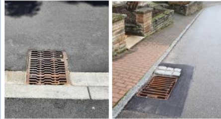
Optimierter Straßeneinlauf Bergeinlauf (mit Optimierung)
