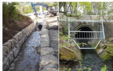
Einlaufbauwerke mit optimiertem Rechen
